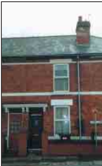
115 Portland Street, Derby DE23 8QD
